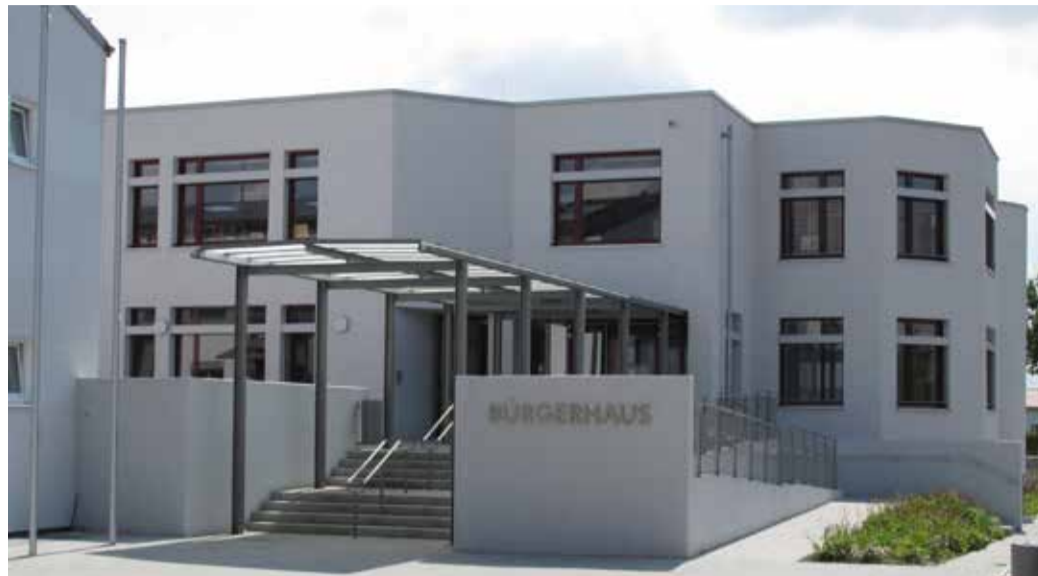
Das Putzbrunner Bürgerhaus
